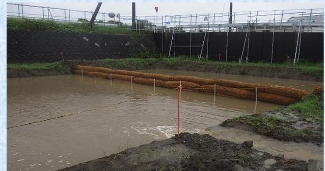
⑤ 現場内の粉塵が場外に飛散しないよう、適宜、現場内散水を行っています。
