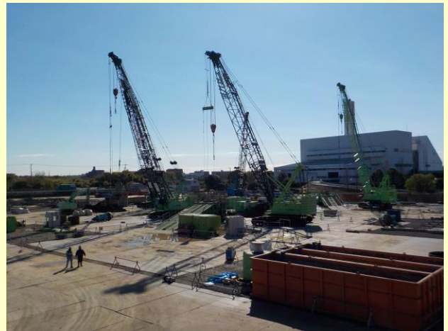
建設現場の様子
