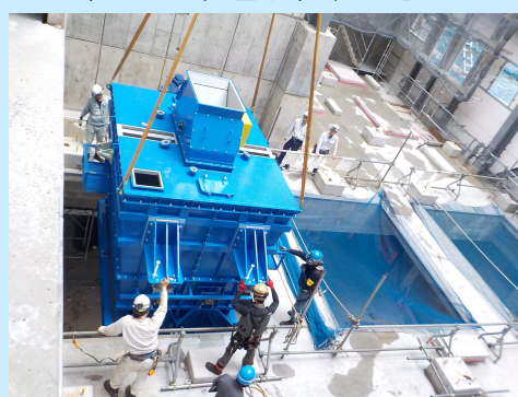
粗大ごみ選別機械の設置
